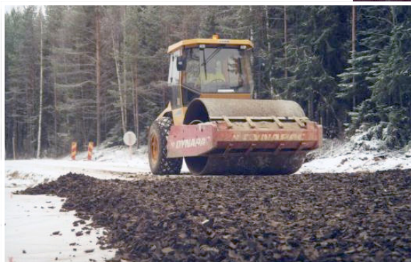
Figur 8.11. Gummiklipp som skyddslager i väg, pågående utläggning och packning.
