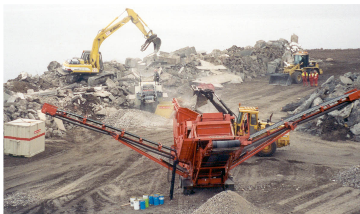
Figur 8.1. Krossning och utbredning av förstärkningslager av krossad betong.
