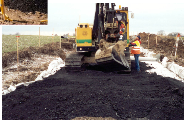
Figur 8.9. Exempel på användning av slaggrus som förstärkningslager. Ovan parkeringsyta i Malmö, till höger gata i Käglinge.
