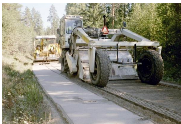
Figur 3.5. Masstabilisering av lösa jordar (ovan), stabilisering av bär- och förstärkningslager i grusväg genom inblandning av flygaska (nedan).
