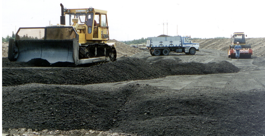
Figur 8.10. Exempel på användning av kolbottenaska som lätt bankfyllning, E4 Åby-Norrköping.
