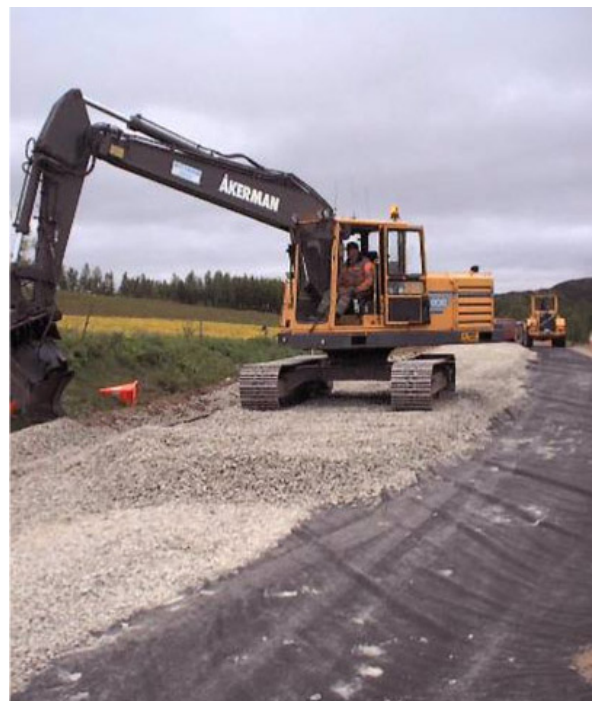
Figur 8.4. Skumglas som isoleringsmaterial utlagd på ena väghalvan.
