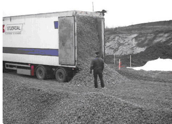
Figur 8.3. Släpvagn som står på en skumglasfyllning och tippar sin last.
