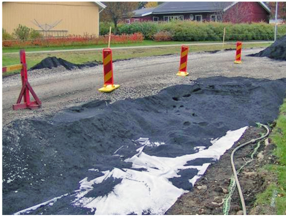
Figur 3.6. Isolering med skumglas (ovan) och järnsand (nedan) för att minska tjällyftning samt förbättra tjällossningsbärigheten och beständighet hos konstruktionen.
