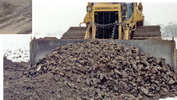
Figur 8.1. Krossning och utbredning av förstärkningslager av krossad betong.
