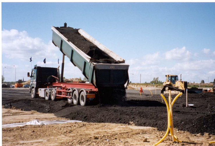
Figur 8.9. Exempel på användning av slaggrus som förstärkningslager. Ovan parkeringsyta i Malmö, till höger gata i Käglinge.
