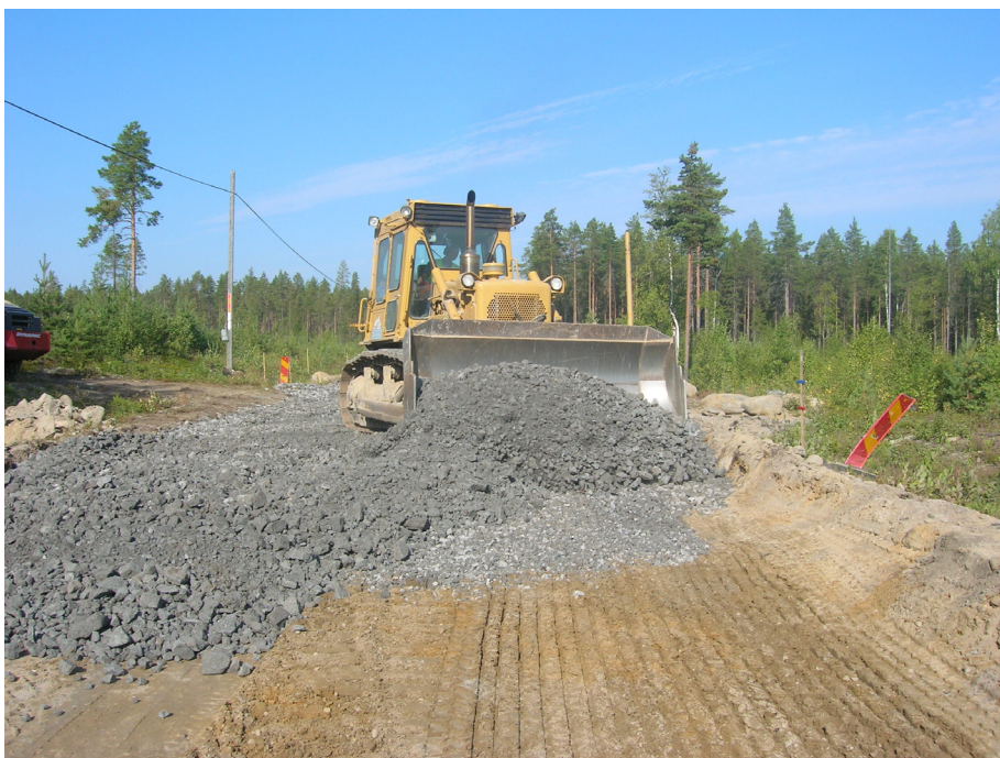
Figur 8.2. Utläggning av hyttsten.
