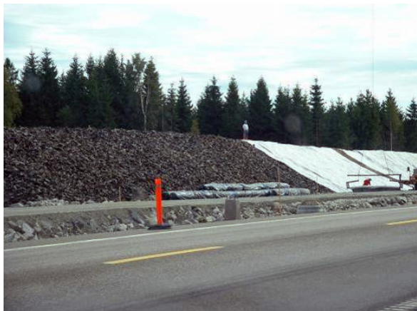
Figur 3.4. Lättfyllning med skumglas i väg (ovan) och gummiklipp i bullervall (nedan).
