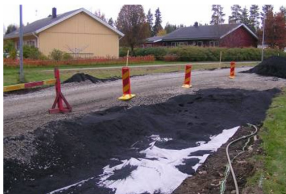
Figur 8.5. Utläggning av järnsand i gata i Bergsbyn, Skellefteå.
