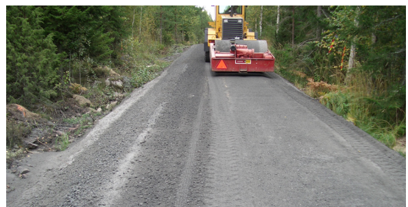
Figur 8.8. Exempel på användning av flygaska i bär- och förstärkningslager i grusvägar (tv Uppsala, th Hallstavik).
