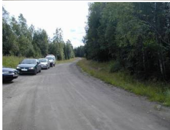
Figur 3.3. Materialersättning med slaggrus som förstärkningslager i gata (ovan), ferrokromslag i väg (mitten) och bottenaska i grusväg (nedan).
