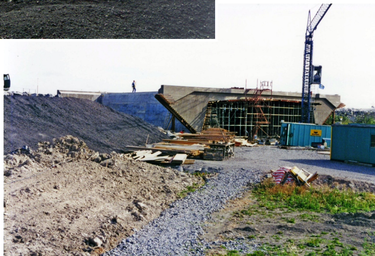
Figur 8.10. Exempel på användning av kolbottenaska som lätt bankfyllning, E4 Åby-Norrköping.
