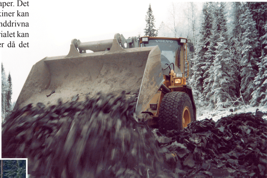
Figur 8.11. Gummiklipp som skyddslager i väg, pågående utläggning och packning.
